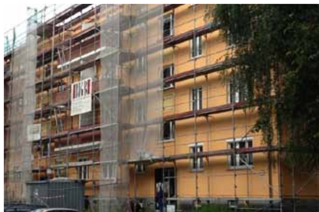
Eingekleidete Fassade der Schönstraße 66/67
