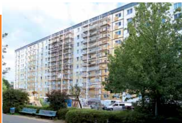
Bautenstand August 2015 / Falkenberger Straße 27–30
